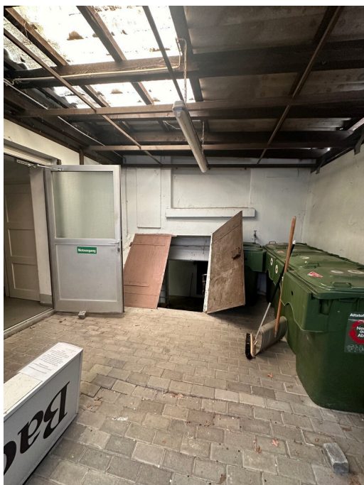
Hinterhof mit Kellerzugang
